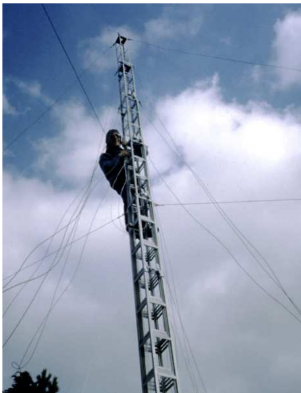
Installation du mât. (CARHOP, Fonds T. Couvreur)
